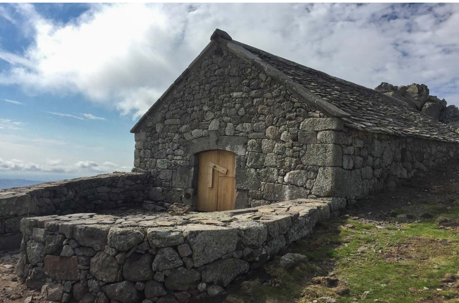
Buron du Cassaïre rénové lors d'un chantier porté par le Grand Site - Julien Couty
