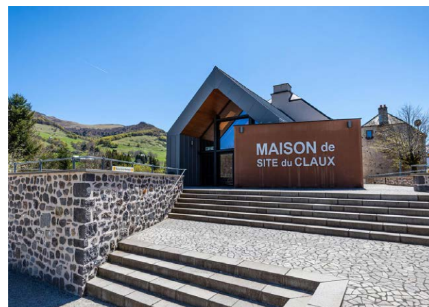
Rénovation énergétique de la Maison de Site du Claux : mise en place d'une chaufferie bois et valorisation du patrimoine bâti.
