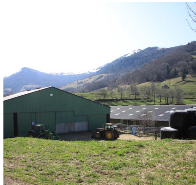
Réutilisation et valorisation du bâti agricole vieillissant.
