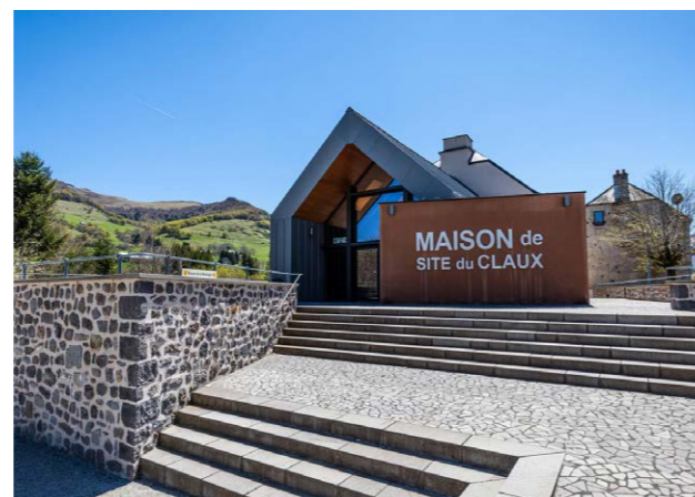
Rénovation énergétique de la Maison de Site du Claux : mise en place d'une chaufferie bois et valorisation du patrimoine bâti.
