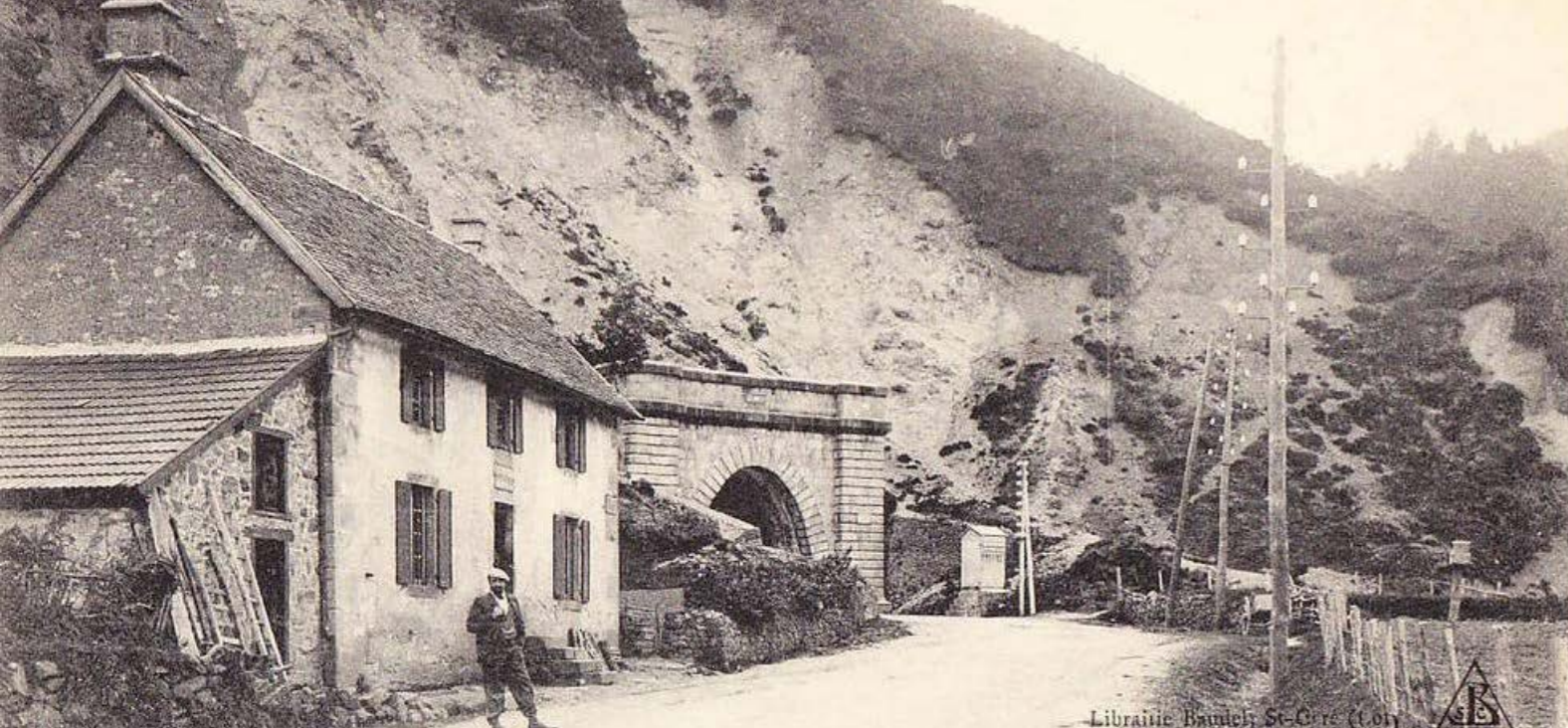
La création du tunnel du Lioran, un marqueur emblématique des évolutions de la mobilité sur le Grand Site de France - source web
